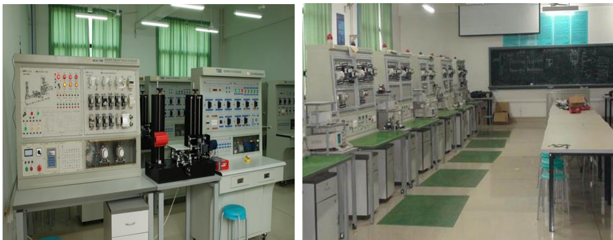
电气技能实训室
