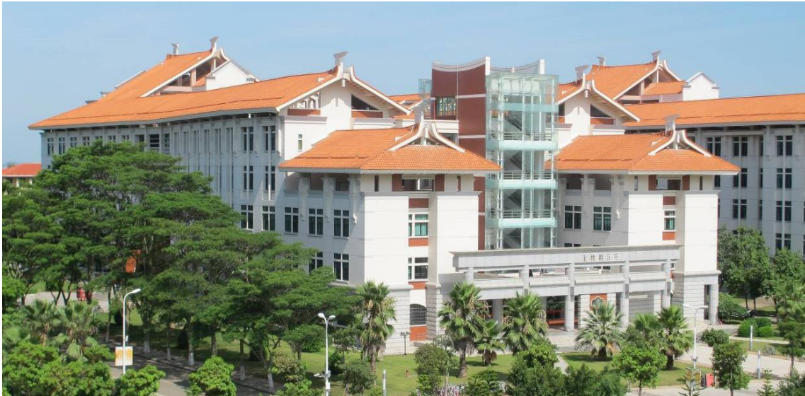
A 座 主楼群 5 号 西门 主入口
