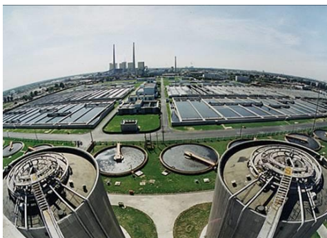
污水处理厂运行管理
