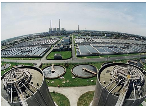
污水处理厂运行管理
