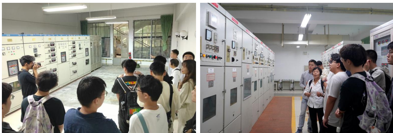
校内供配电系统参观实习
