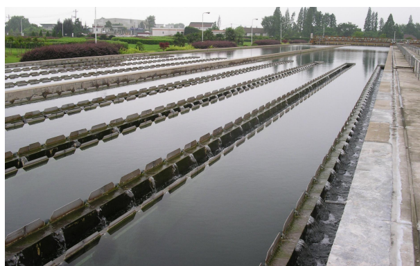
市政给排水系统的建设和运行管理
