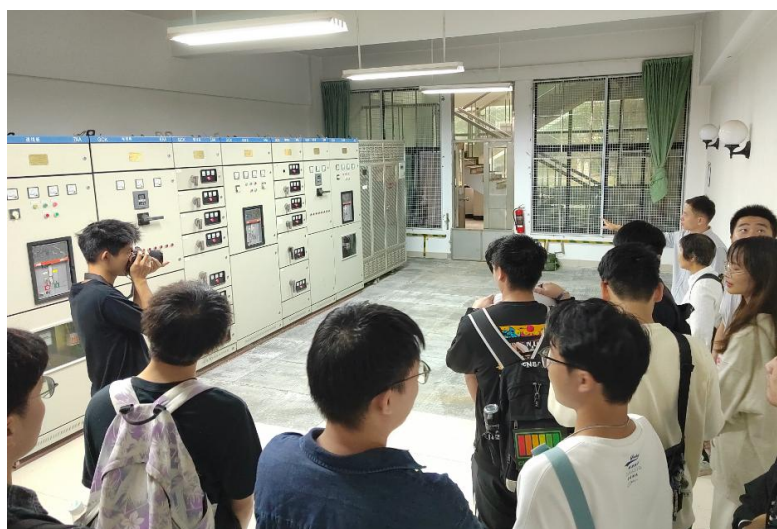
供配电系统参观实习
